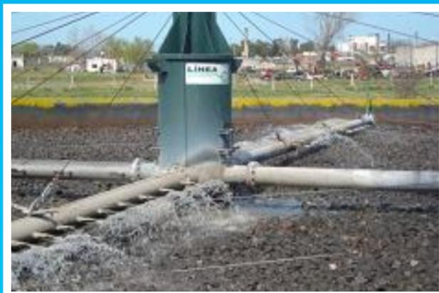
El lecho percolador consta de un manto de piedra de 1,80 m de alto, con un falso fondo de 1,10 m en su máxima altura. Esto permite mantener una buena ventilación inferior del lecho ya que circula entre las piedras el aire que ingresa por las ventanas laterales de la estructura, manteniendo el medio aerobio. Las películas biológicas de bacterias, protozoarios y hongos que se forman en la superficie media de las piedras, reducen los contenidos orgánicos.
